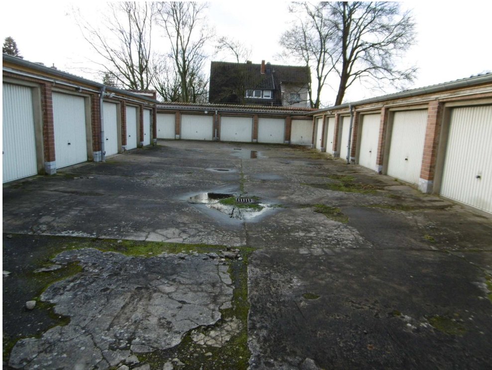
Garagenhof Pyrmonter Str. 53 vor der Sanierung
