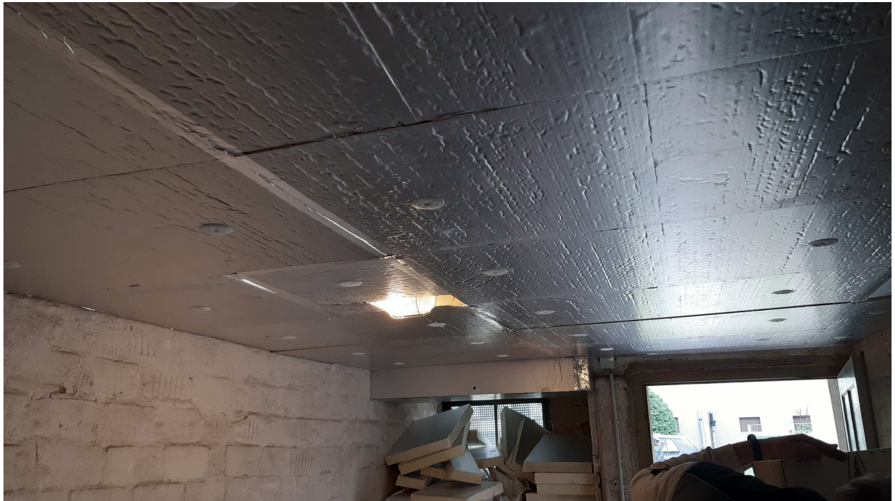
Kellerdeckendämmung Quellengrund
