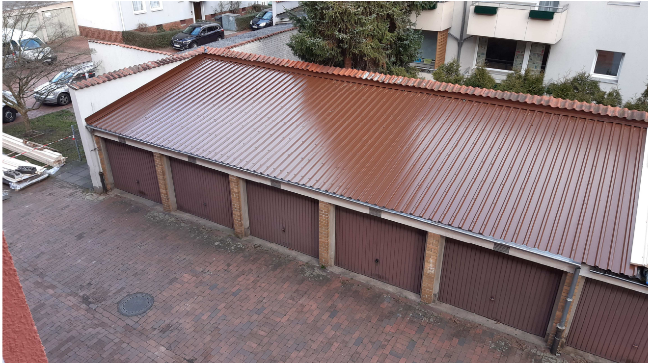
Sanierung von 14 asbestbelasteten Garagendächern Quellengrund 5-7
